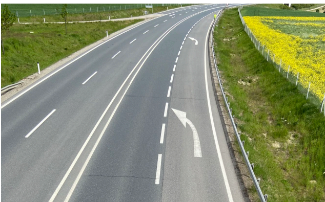
ABB 1. Erhebung des Fahrverhaltens an einem Beschleunigungsstreifen in Maissau, NÖ
